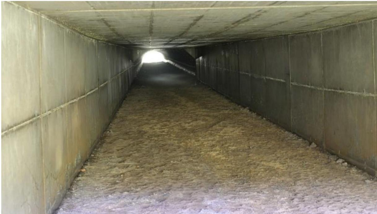
Abbildung 18: Innenansicht des Fledermausdurchlasses; Blick nach Westen. Der Untergrund besteht aus unbefestigtem Erdboden. Das Bauwerk hat eine Länge von 159,50 m und eine lichte Weite von 3,60 m. Die Fertigstellung erfolgte im März 2016.
