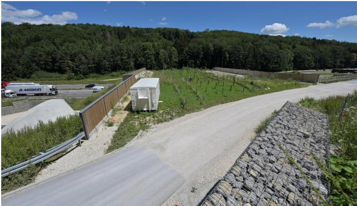
Abbildung 5: Blick von Westen auf die Grünbrücke. Auf der Grünbrücke ist der Container zu sehen, der während der Bauphase als Wasserspeicher diente. Im Vordergrund ist ein Teilstück der Gabionenwand zu sehen und der Übergang der asphaltierten Wegeführung zur wassergebundenen Decke zu sehen. Aufnahmedatum: 01.07.2020.
