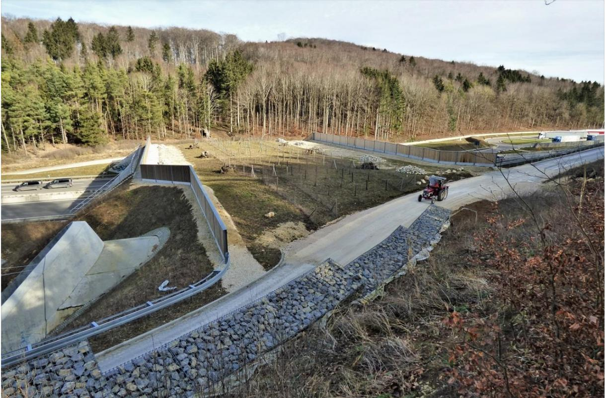
Abbildung 2: Blick auf die Faunabrücke Imberg von Westen oberhalb der Gabionenwand. Mittig auf dem Bauwerk ist ein Gras- und Krautflur gesät mit eingezäunten Pflanzungen. Die Seitenstreifen hin zu den Irritationsschutzwänden bestehen aus Kies und Sand und sind nicht bepflanzt. Aufnahmedatum 31.03.2020.
