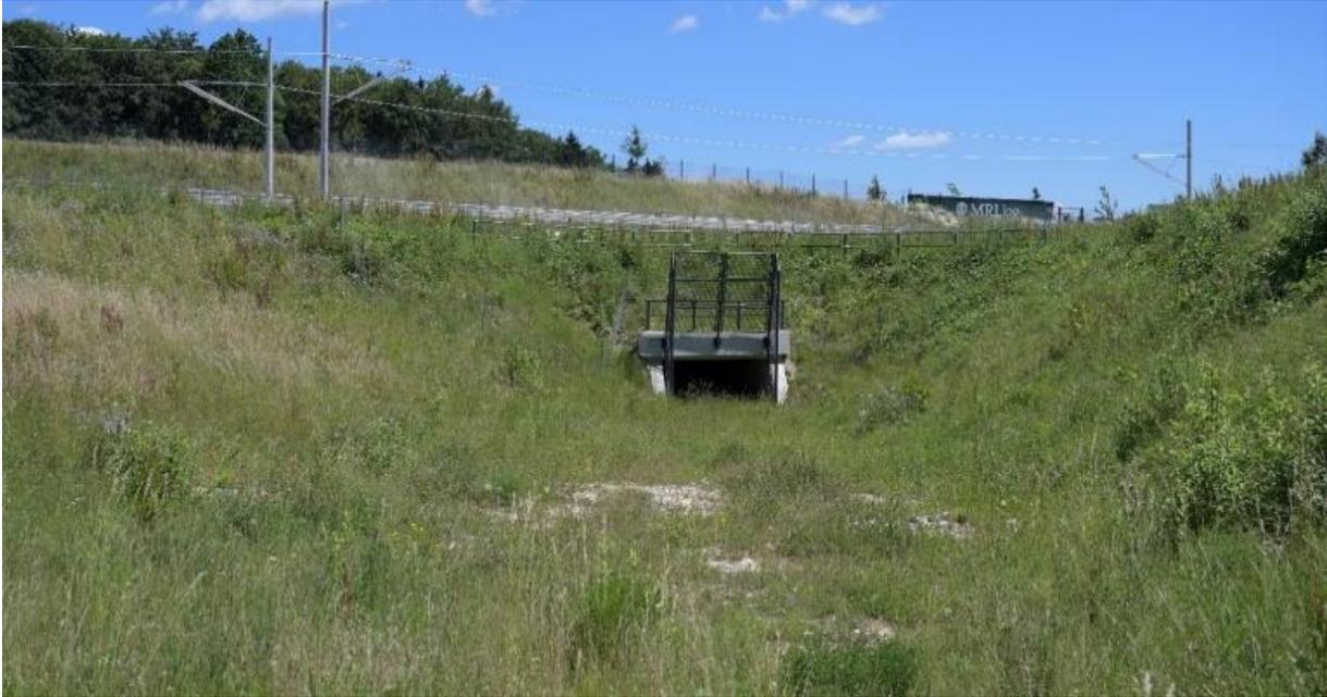
Abbildung 15: Eingang des Fledermausdurchlasses Wanneweg auf der Westseite der Autobahn. Vor dem Eingang liegt eine offene Landschaft mit Böschung an beiden Seiten. Zukünftig soll hier eine Baumreihe als Leitstruktur aufwachsen. Aufnahme am 01.07.2020.
