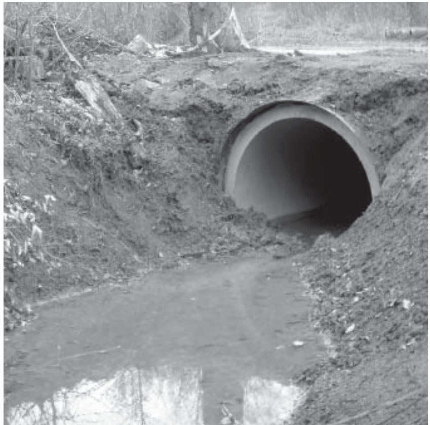
Ausreichend dimensioniertes Betonrohr (Foto: Gerhard Schaber-Schoor, FVA)
