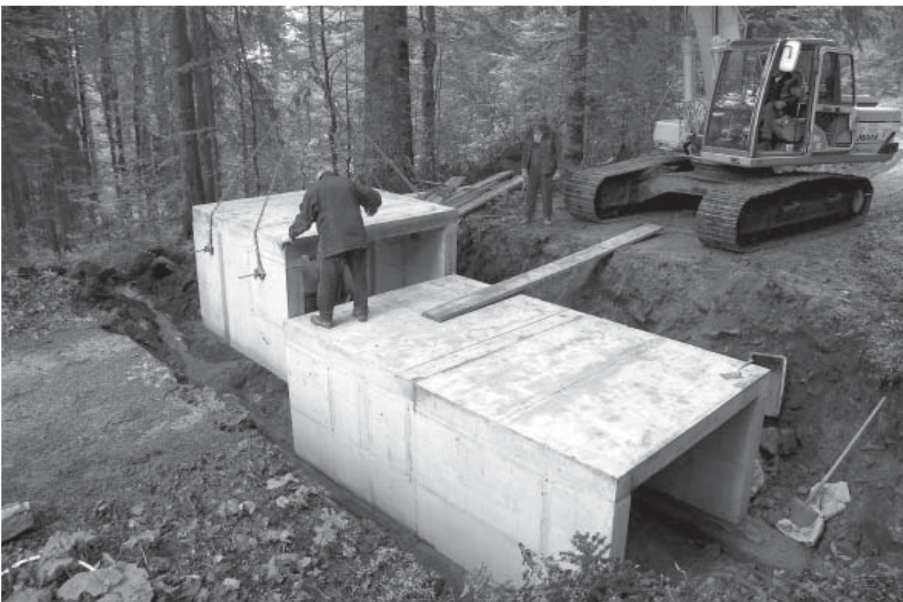
Durchgängigkeitsmaßnahmen: Bau einer Brücke in Haubenprofilbauweise (Foto: Gerhard Schaber-Schoor, FVA)
